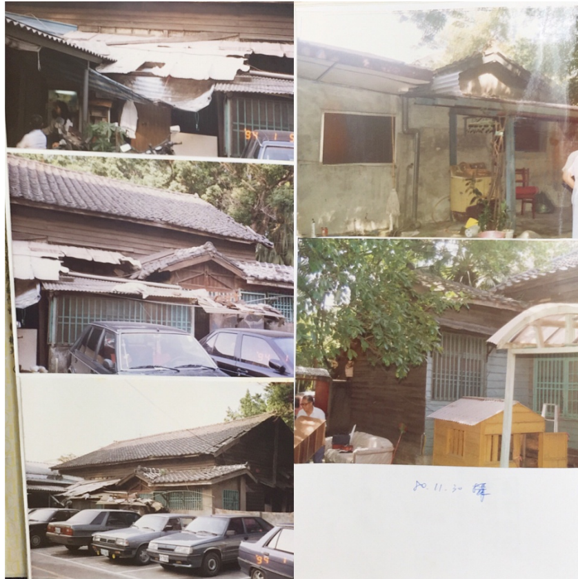
圖 3-20-1：博愛路 125 號拆除前夕情況
